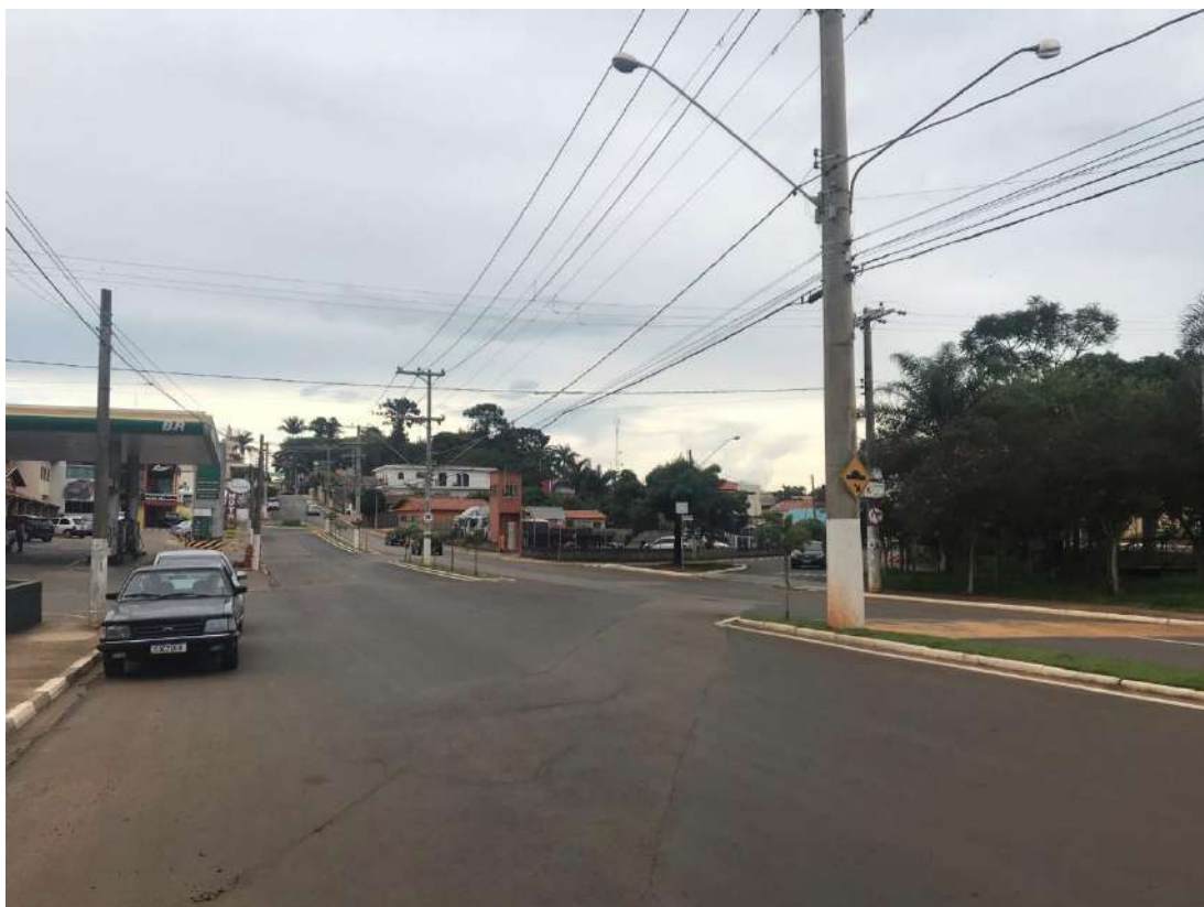
Figura 7-7 – Ponto crítico de alagamento 2 Fonte: CONSÓRCIO CM (2021)
