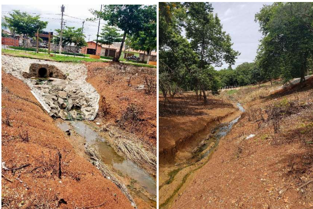
Figura 7-3 – Sistema de macrodrenagem e córrego com assoreamento próximo à Praça Gumercindo de Camargo Barros Fonte: CONSÓRCIO CM (2021)
