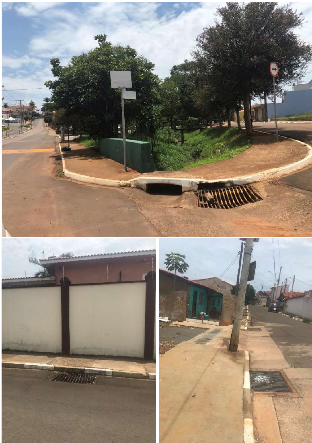
Figura 7-4 – Exemplos de dispositivos de captação de águas pluviais Fonte: CONSÓRCIO CM (2021)
