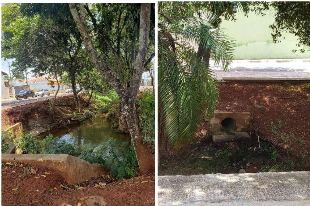
Figura 7-2 – Córrego da Bica e exemplo de um ponto de lançamento de águas pluviais no córrego, na Avenida Benedito C. de Barros Fonte: CONSÓRCIO CM (2021)
